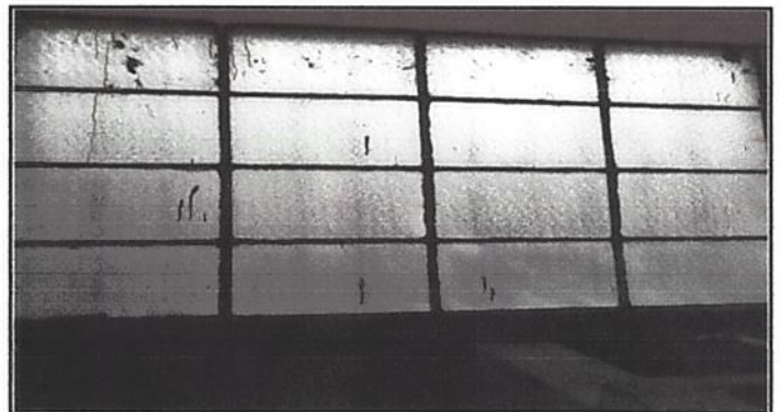
Foto 4: Sustrucción de ventanas de madera por metal mas vidrio
