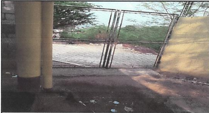
Foto 1: Sustrucción de portón de metal por porton de metal por 3.90x2.50
