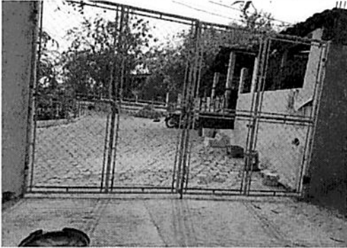
Foto 1: Sustitución de porton de metal por porton de metal de 3.90 x 2.50
