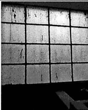
Foto 5: Sustitucion de ventanas de metal por pvc más vidrio
